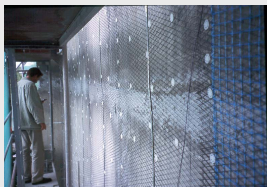
Gemonteerd LIDA NET anode- systeem
