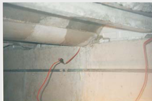
Na reparatie voorzien van "Anode-aansluitingen"
