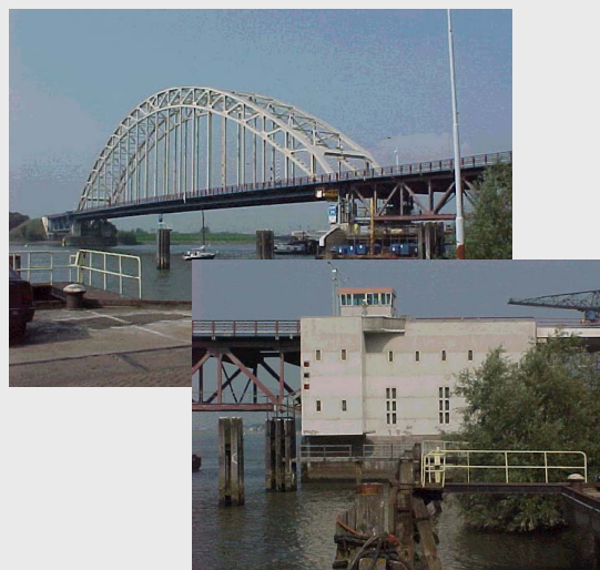
De "Brug over de Noord" basculekelder
