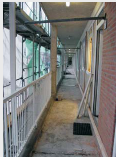
Galerij tijdens renovatie
