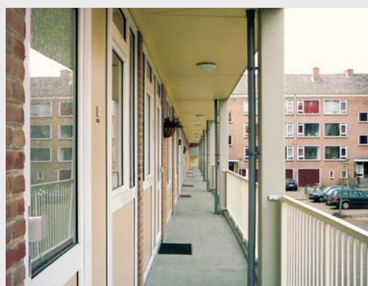
Galerij na renovatie
