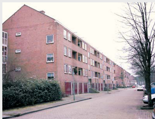
Een deel van het complex "Persijn" met loggia's
