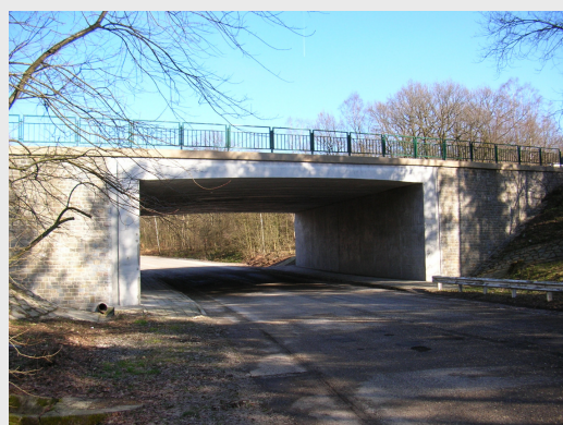
Een definitief corrosievrij viaduct
