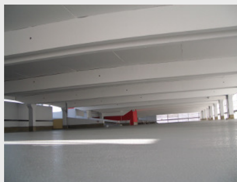
12.000 m 2 corrosievrij parkeerdek
