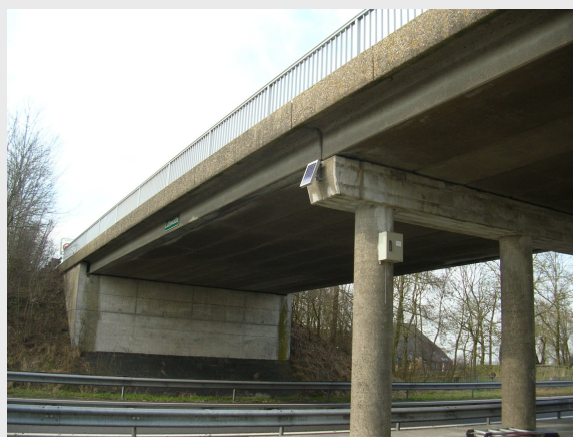
Solar energievoorziening met KB-kast
