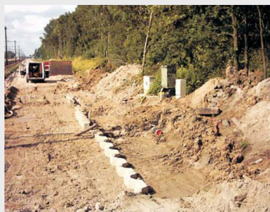
Damwanden op locatie
