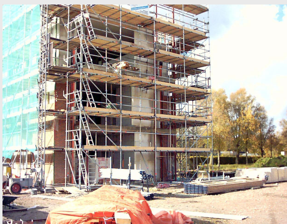
Kantoor villa in aanbouw
