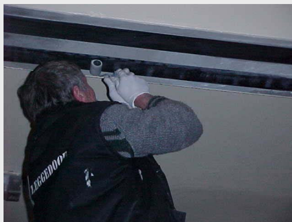
Het aanbrengen van Koolstof lamellen
