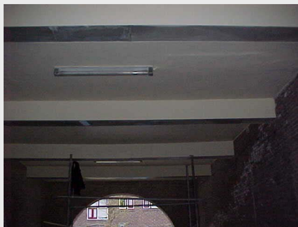
Een volledig gerenoveerde en versterkte onderdoorgang
