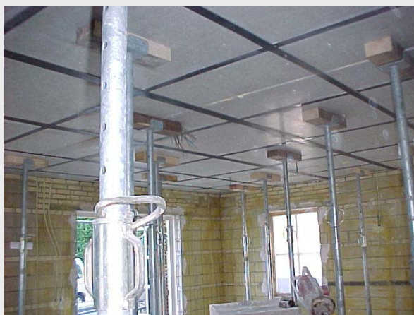
De volledig versterkte verdiepingsvloer
