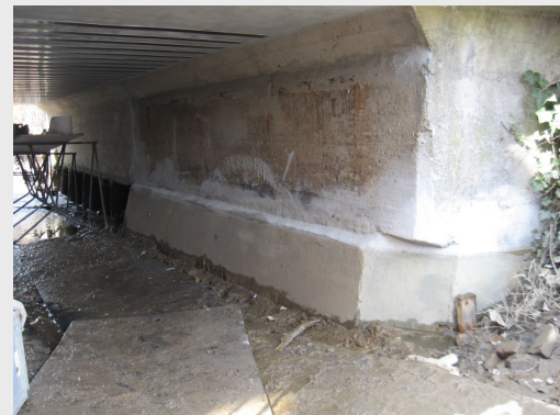
Nieuwe fundering, koolstof lamellen bevestiging
