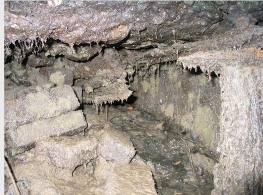
Aanvang van het werk, houten fundering
